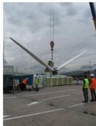
Assemblaggio della navicella e montaggio a terra delle pale 1 e 2.
