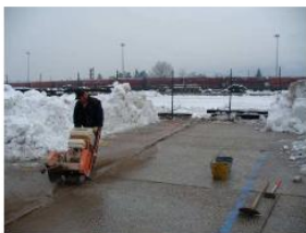
Taglio della pavimentazione
