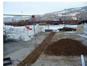
Scavo linea di connessione e ripristino
