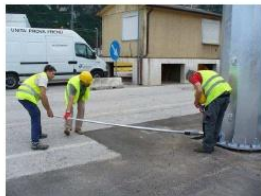
Controllo e regolazione verticalità, serraggio bulloni con chiave dinamometrica.
