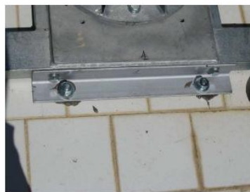
Fissaggio mediante tassellatura con resina bicomponente.
