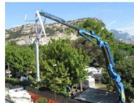
Sollevamento e posizionamento del rotore VAWT mediante camion gru.
