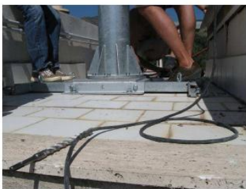
Fissaggio mediante tassellatura con resina bicomponente.
