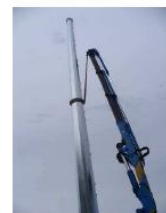
Assemblaggio a terra torre HAWT
