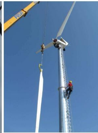
Montaggio navicella e pala 3
